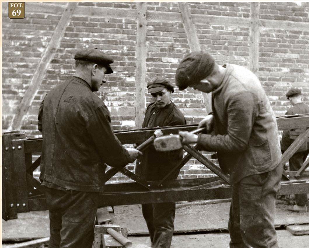
Fot. 69 – Nitowanie słupa kratowego dla linii 60 kV Gródek – Grudziądz. Zdjęcie wykonano latem 1928 r.
