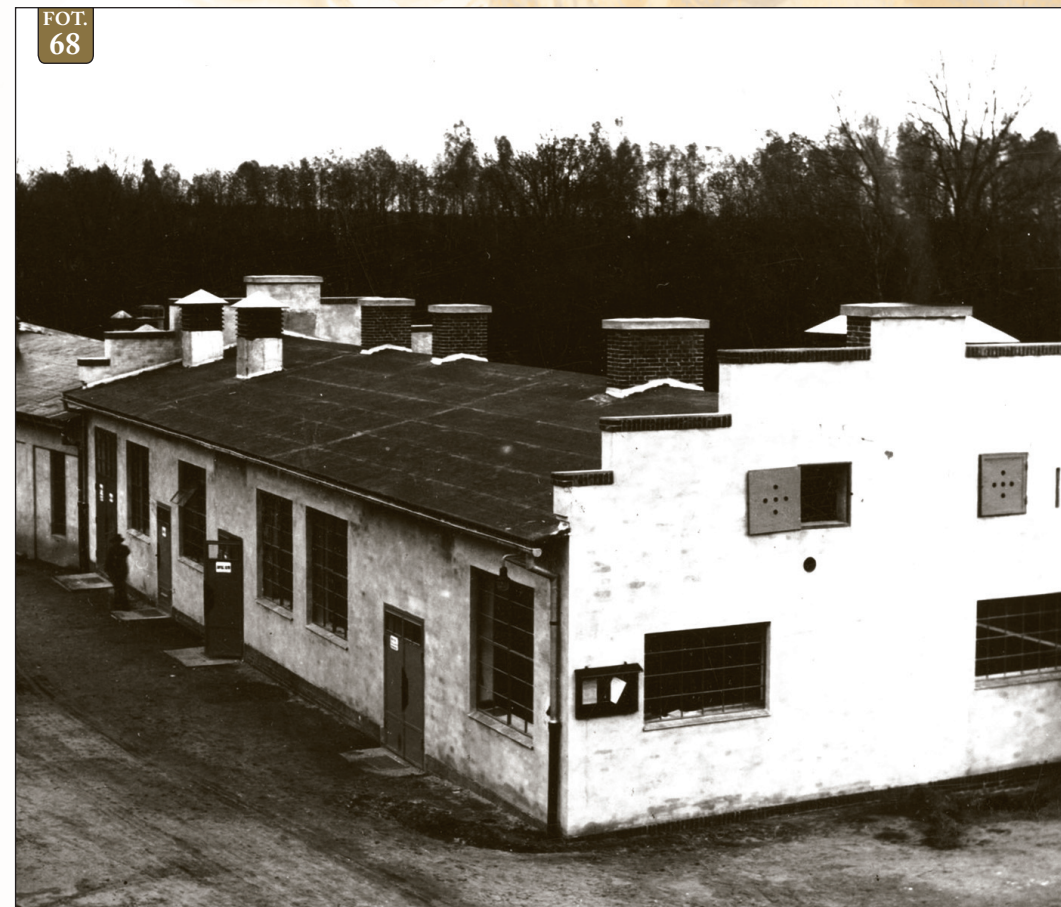
Fot. 68 – Budynki warsztatów mechanicznych w Gródku w marcu 1934 r.
